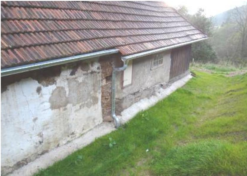
Die hangseitige Außenmauer wurde freigelegt und mit Beton unterfangen. Neue Dachrinnen leiten das Regenwasser in den Kanal.
