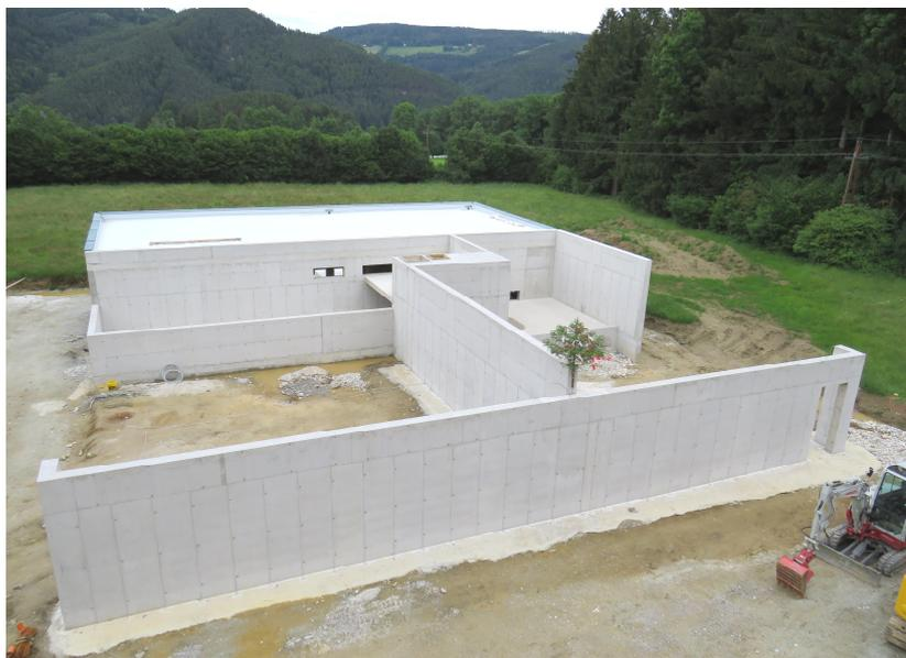
*Im Vordergrund befinden sich zwei Lagerräume für Hackgut. Im gedeckten Bereich werden die Holzvergaser und Hackschnitzelheizungsanlagen untergebracht.*
