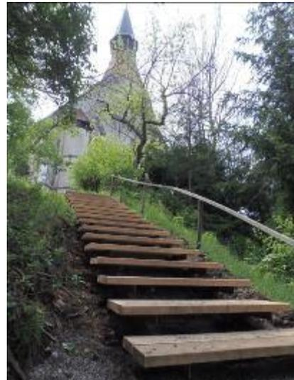
*Der Fußsteig zur Wolfgangskirche wurde von der Gemeinde generalisiert. Die Stiegen bestehen nun aus einer Eisenunterkonstruktion, auf der die Stufenbretter montiert sind. Damit ist eine längere Lebensdauer des Holzes gegeben.*
