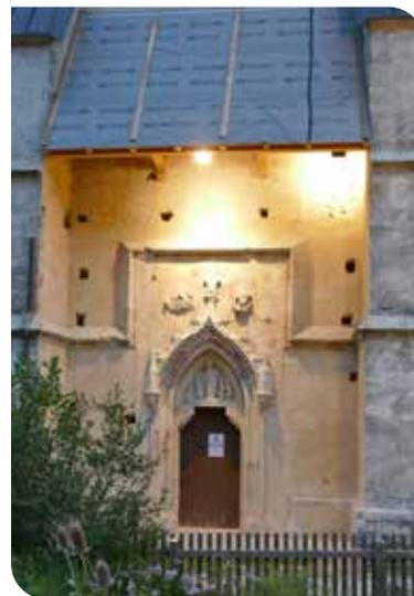
Das neue Vordach wurde höher (in die ursprüngliche Position) gesetzt. Die Ausführung aus Lärchenholz und mit Kupferblecheindeckung erfolgt analog dem Vordach über dem Hauptportal. Es bleibt unten offen, man hat also jetzt freie Sicht auf die zugemauerte Tür. Eine Beleuchtung des Portals und des Vorplatzes erfolgt mit LED-Scheinwerfern und verleiht dem Nordportal in den Abendstunden (bei Bedarf) einen eigenen Zauber.
