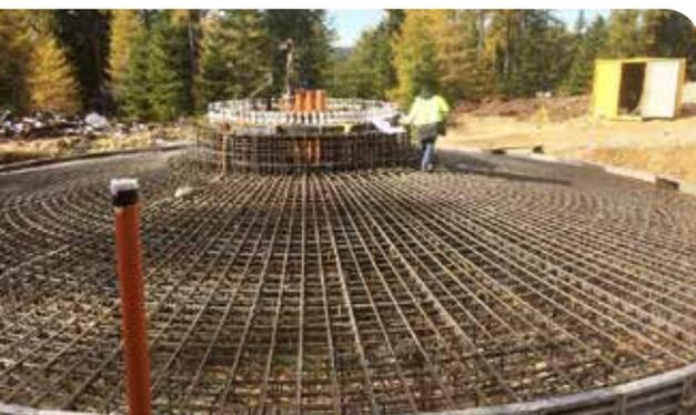
*Die Fundamente der heutigen Windräder (185 m Gesamthöhe) weisen einen Durchmesser von 20 m auf und sind nur 2 – 3 m tief.*
