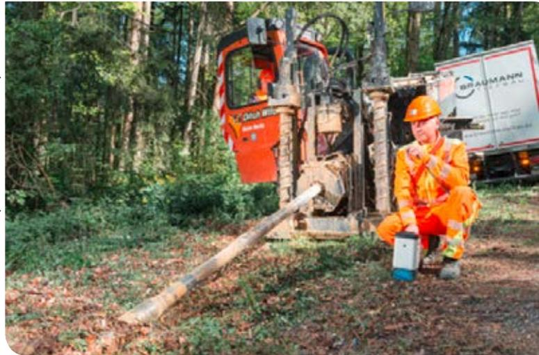
Außerdem können mit einer Spülbohrung Straßen durchgebohrt werden. Das erspart eine aufwändige Wiederherstellung. Bei uns wurde damit unter die Ramsstraße und sogar unter dem Ramsbach der Kanal verlegt. (ähnlich wie am Bild dargestellt)
