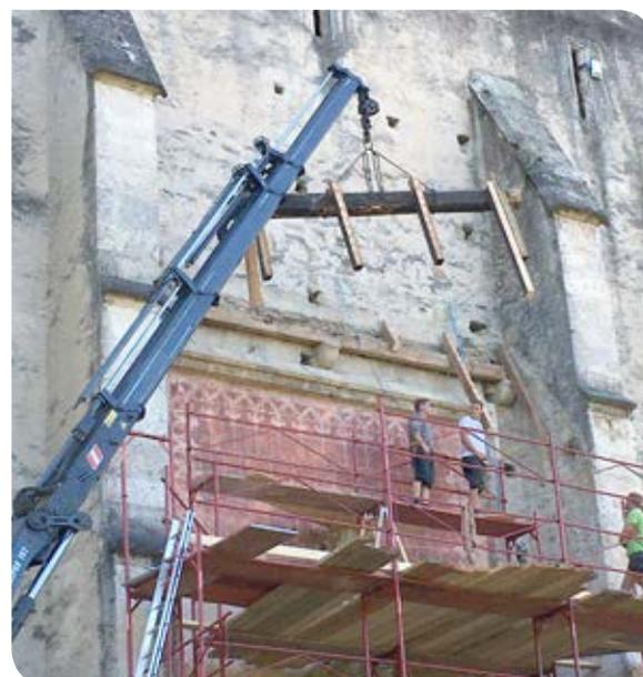
Gerüstung und der Neuerrichtung des Dachstuhles in massivem Lärchenholz beauftragt. Die Arbeiten wurden zügig durchgeführt und sind abgeschlossen.
